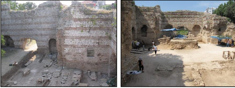
Şekil 19. IV nolu mekân 10-12 nolu duvarlara bakış
