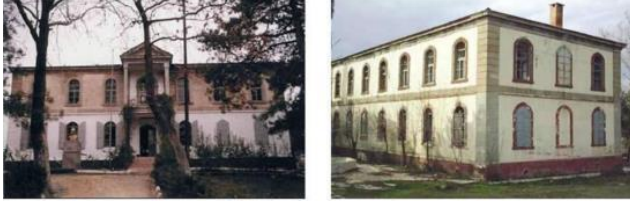
Resim 7. Sındırgı Redif Yapısı (Özgen, 2016)
