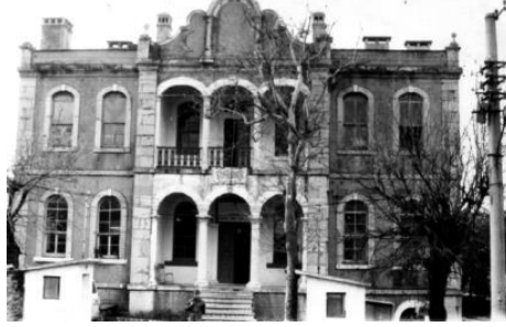
Resim 16. Bandırma Redif Kışlası'nın atıl kaldığı görsel (Ülker, 2019)
