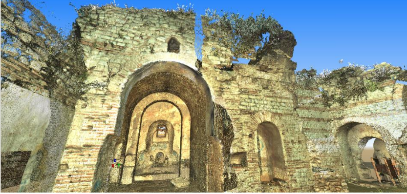
Şekil 20. Laserscanner ile oluşturulmuş Kilise iç mekânı doğu duvarı ve kilise dış batı duvarına bakış
