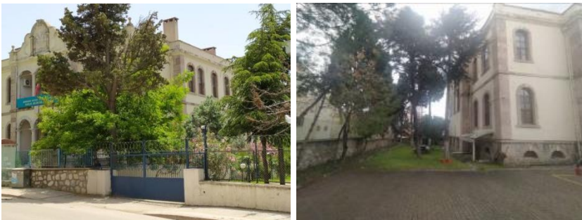
Resim 20. Redif binası batı cephesi, Redif binası arka cephe, 2021
