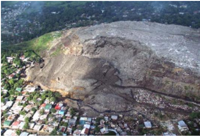
Şekil 2- 2000 yılında Payatas depolama sahasında şev göçmesi
