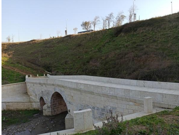
Görsel 10: Hasanderesi Köprüsü'nün Mevcut Durumu (Kaynak: https://kulturelmiras.ibb.istanbul/hasandere-koprusu/ )
