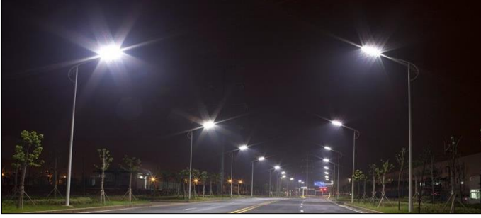
Şekil 21. Akıllı yol aydınlatması (Alfazal Engineering, 2024).
