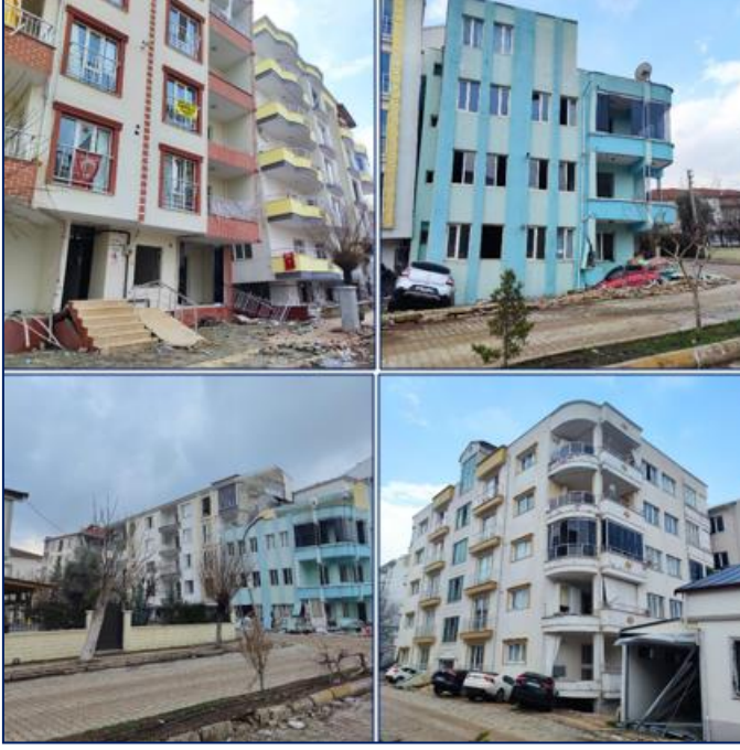
Şekil 4. Sıvılaşmaya bağlı olarak zeminde oturma nedeniyle 6 Şubat 2023 depreminde Adıyaman Gölbaşı'nda hasara uğrayan binalar
