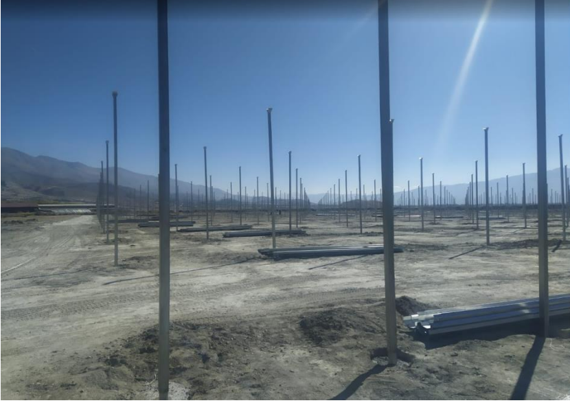
Resim 1. Erzincan Akyazı Modern Sera İnşaat sahasında kolonların montajı
