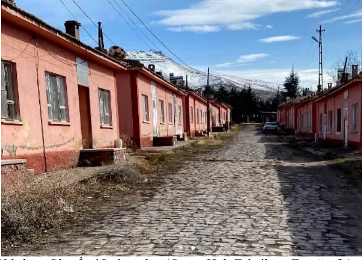
Şekil 16: Yıkılmış Olan İşçi Lojmanları (Saray Halı Fabrikası Fotoğraf Arşivi 2000’li yıllar)
