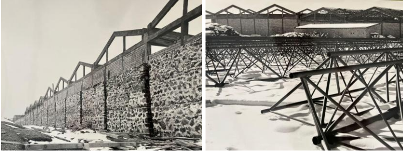
Şekil 5: Develi Saray Halı Fabrikası inşasında kullanılan çelik konstrüksiyon örnekleri (Saray Halı Fabrikası Fotoğraf Arşivi, 1973)
