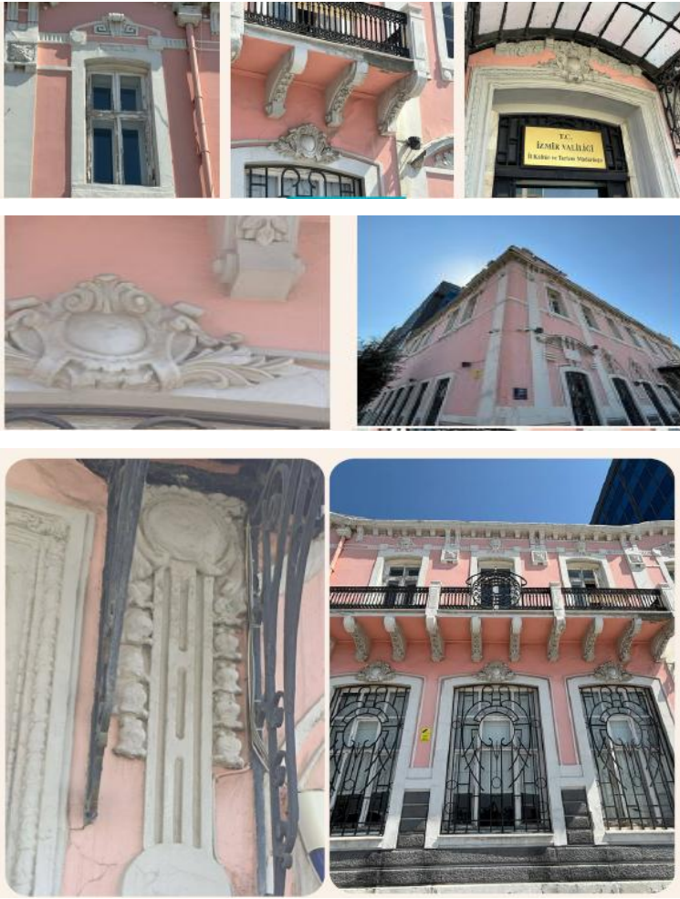
Şekil 8: İzmir İl Kültür ve Turizm Binası
