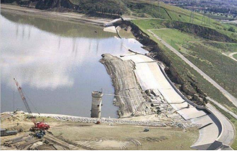
Şekil 1. San Fernando (1971) depreminde sivilaşma sonucu oluşan hasarlar (Kramer, 1996).
