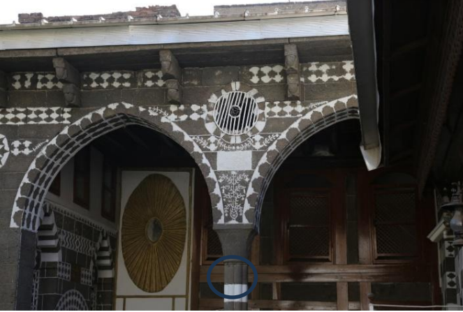
Şekil 3. Güney Cephesi eyvan kemerler ve kitabe (2017)
