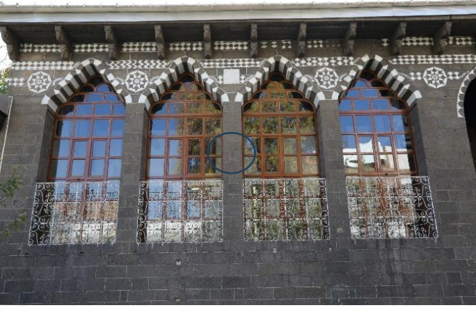
Şekil 2. Güney Cephesi pencereleri ve kitabe (2017)
