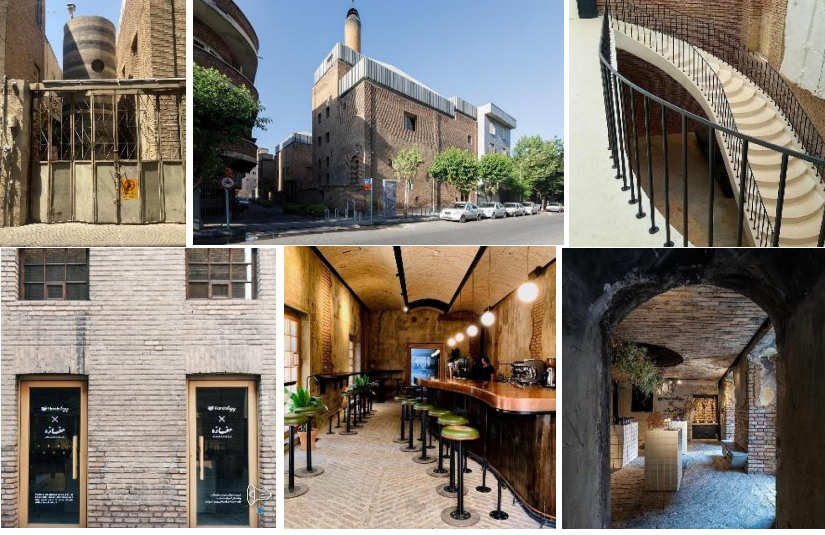
Şekil 8: Palimpsest yaklaşımın fiziksel dönüşümdeki izleri; sırasıyla yapıyla uyumlu çağdaş ek silindirik yapı, çağdaş yüzen çatı, yerinde döküm beyaz beton merdiven, çağdaş görünümlü ahşap-cam kapılar, kafeterya iç mekânında parlak yüzeyli ahşap mobilyalar ve siyah metal parçalar, satış alanında modern seramik kaplı stantlar (yazarların arşivi).
