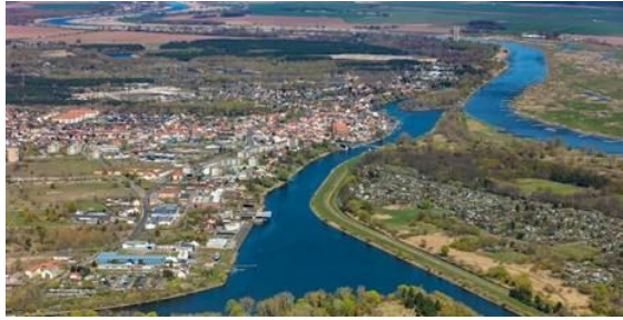
Şekil 30. Eski Kent Merkezi Fürstenberg ile VI tip prefabrik yapıların buluşması (Kanala paralel sıralı Beş katlı Prefabrik Yapılar) (Lötsch, 2022)
