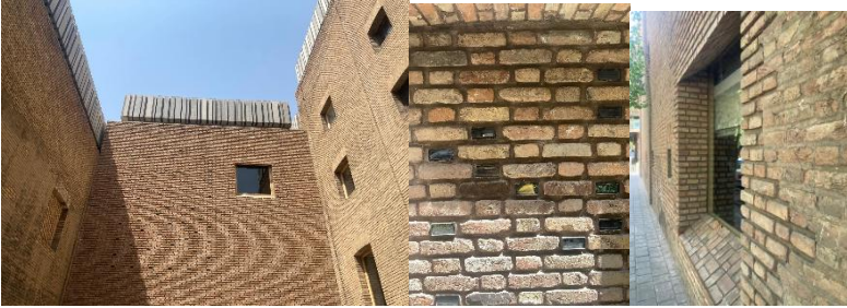
Şekil 7: Yapının duvarlarındaki mevcut tuğlalar ile restorasyon sonrası hasar görmüş tuğlaların kullanımı (Yazarların arşivi)
