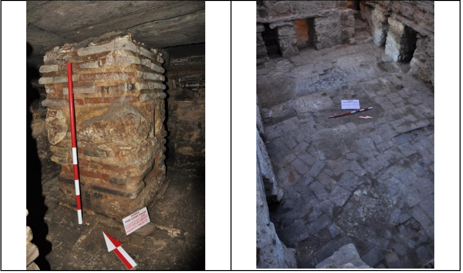
Şekil 7. Cehennemlik bölümünde taşıyıcı ayaklar, almasıık örgü ve döşeme altı boşluklarının görünümü (Özer, 2013); hamamın teknik sisteminin rölöve ve restitüsyon kararları açısından taşıdığı belge değerini ortaya koymaktadır.
