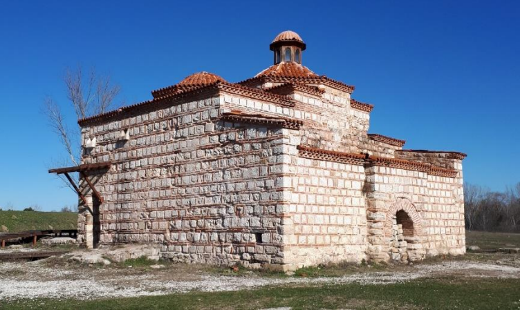
Şekil 13. Kum Kasrı Hamamı'nın uygulama sonrası genel görünümü (Yazarın kişisel arşivi); tamamlanan üst örtü, korunmuş duvar örgüsü ve çevre düzenlemesi yapının fiziksel okunabilirliğini artırmaktadır.
