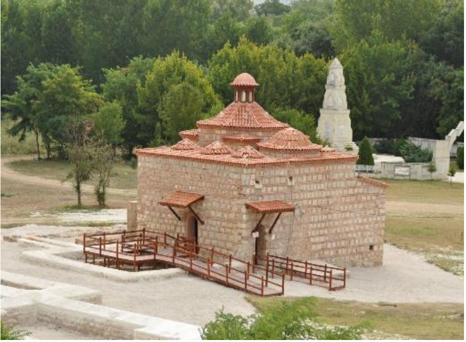
Şekil 15. Kum Kasrı Hamamı’nda uygulama sonrası ahşap dolaşım platformları ve teknik hacim çevresi
