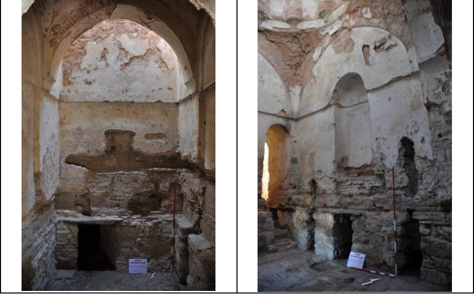
Şekil 6. Sıcaklık bölümünde seki, niş, sıva katmanları ve döşeme izlerinin görünümü (Özer, 2013); mekânsal kullanım izleri ile malzeme bozulmalarının birlikte okunmasına olanak sağlamaktadır.
