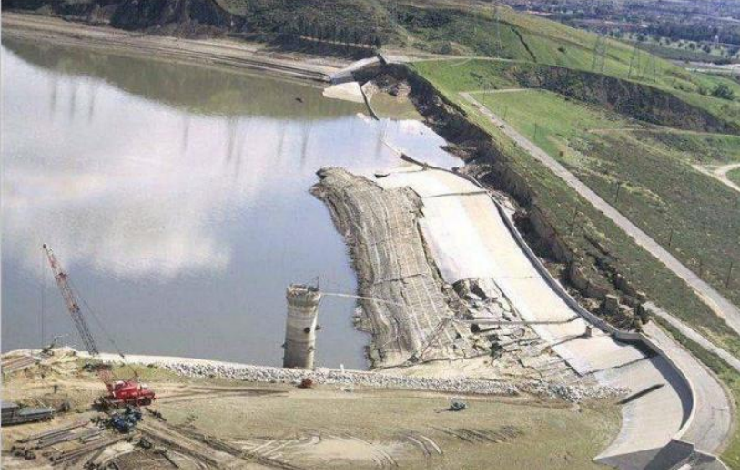
Şekil 1. San Fernando (1971) depreminde sıvılaşma sonucu oluşan hasarlar (Kramer, 1996).
