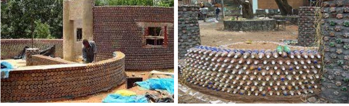
Resim 9. Atık PET şişelerden duvar ve ev yapımı örnekleri (URL-2, URL-5).
