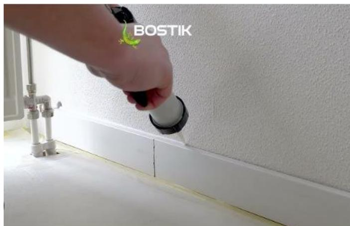
**Bostik FP403 FIRESEAL HYBRID** es un sellador híbrido ignífugo, elástico y pintable. Resistente al fuego hasta 4 horas en juntas lineales (de movimiento).
