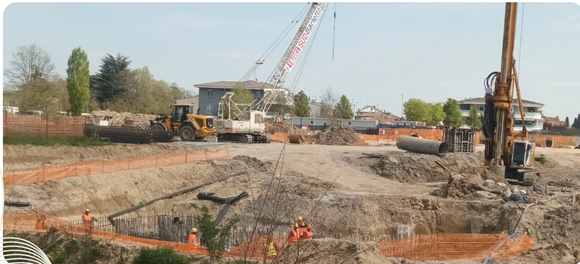
Fondazioni e pilastri per infrastruttura viaria di nuova realizzazione a Forlì
