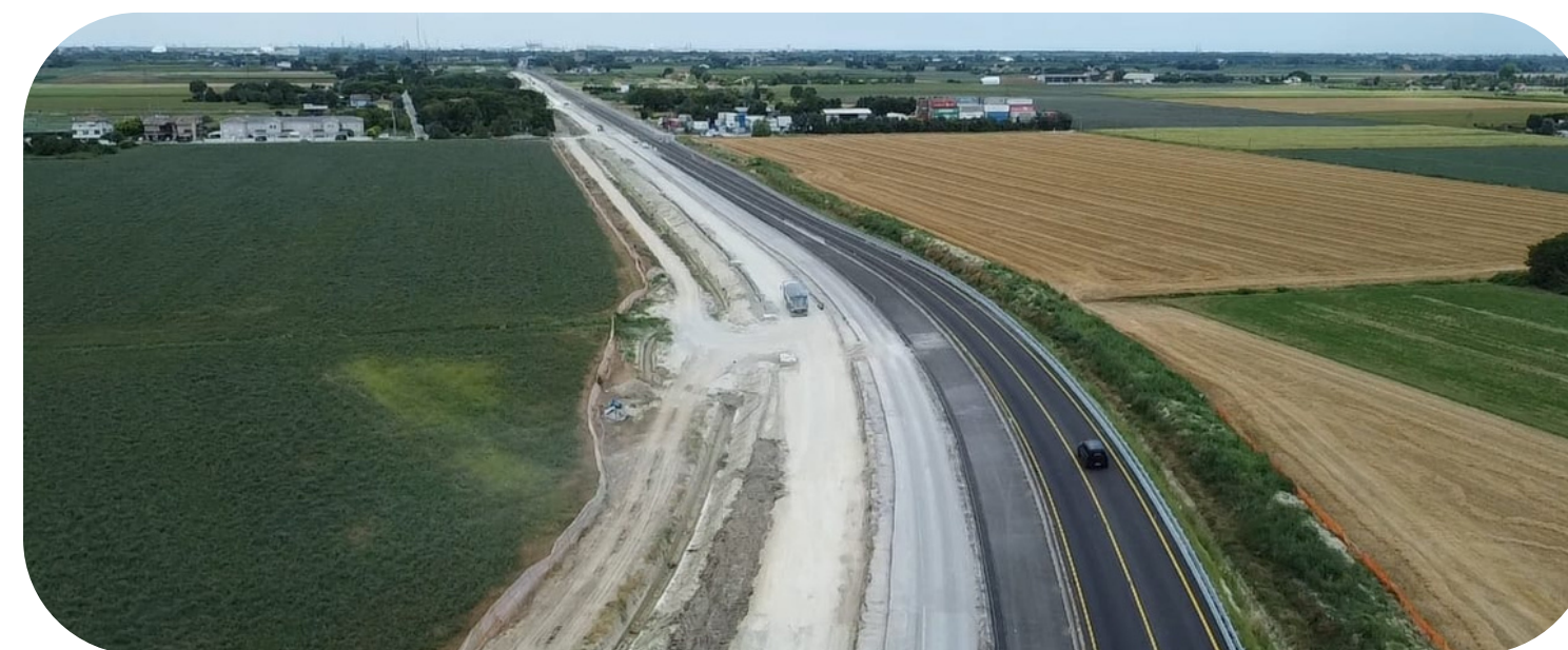
Opere realizzate nell'ambito dei lavori di ammodernamento della SS67 a Ravenna
