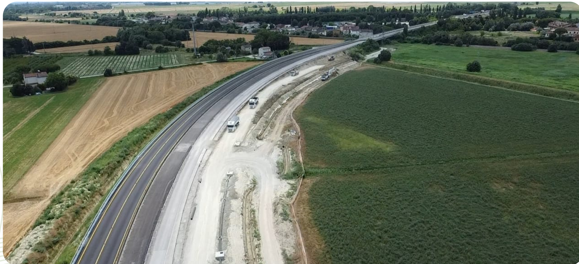
Lavori di ammodernamento SS67, Ravenna
