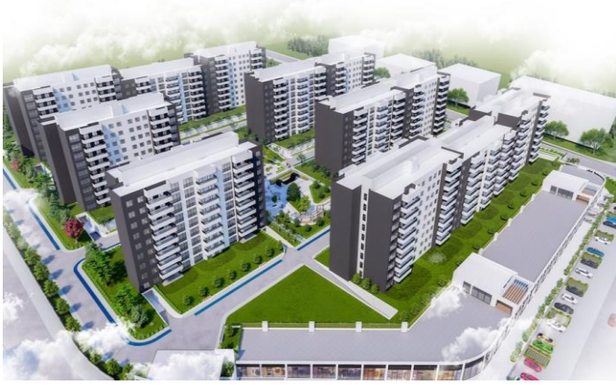
ÖNİZ 500 EVLER TEMEL ve PERDE BETON /SİNCAN /ANKARA ASM İnşaat
