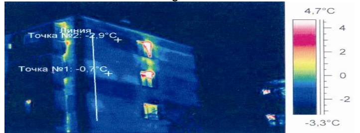
ISOLLAT uygulamasından sonra infrared kamera ile çekilmiş bina görüntüsü
