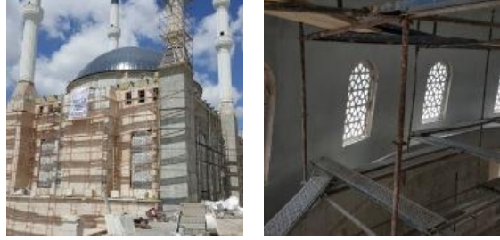
Kıyası Şentürk Camii İç Cephe Isı Yalıtımı Bayburt
