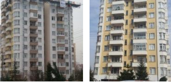
Huzurkent Sitesi Dış Cephe Isı Yalıtımı Konya
