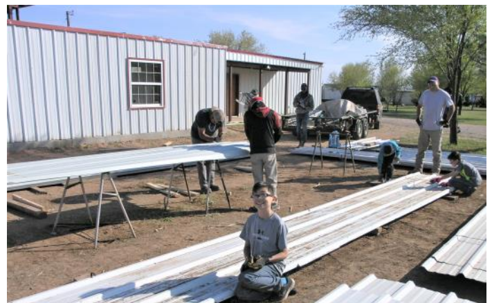
Ralph Mendez y sus hijos ayudan a limpiar los paneles del nuevo techo.
