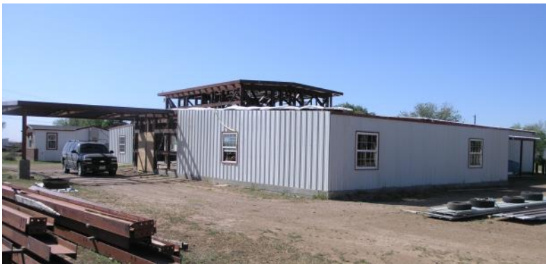
El revestimiento en la sección inferior del edificio está casi completo.
