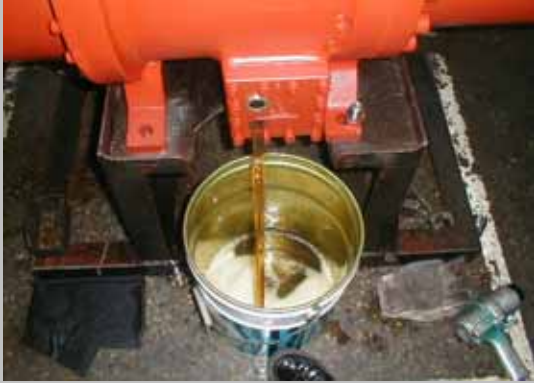
圖 Figure 2-2-1 排放潤滑油/ Drain Oil.
