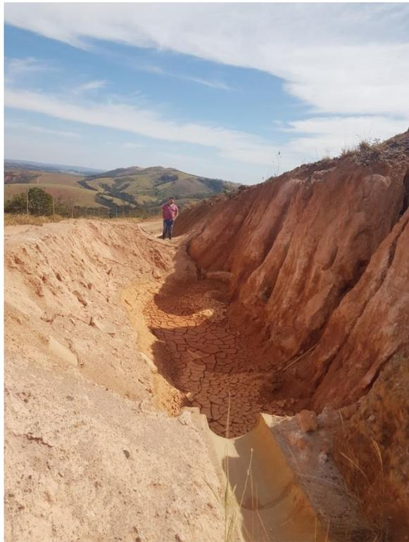
Figura 9 - Canaleta lateral direcionando o fluxo d'água para dique de contenção.
