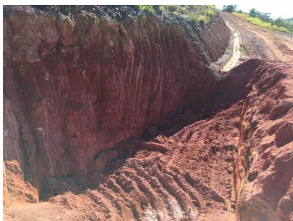
Figura 34 - Sistema de drenagem. Intercepção com bacias de contenção para diminuir a velocidade da água pluvial nas costas do Morro 1.
