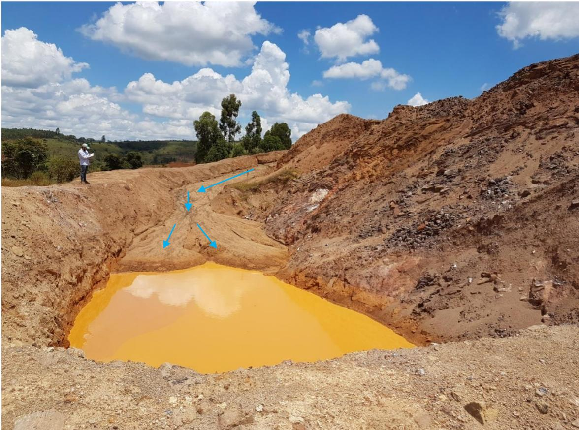
Figura 8- Dique de contenção de água pluvial, destaque para direcionamento do fluxo d'água.
