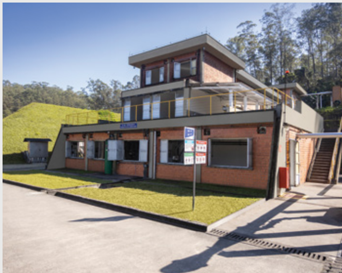
Fábrica de Pólvora CBC Ribeirão Pires - SP
