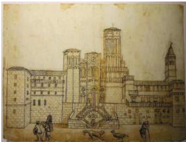
Fig. 44. Dibujo de Vega y Verdugo (1657) con la escalera renacentista y la posible remodelación de los arcos mateanos.
