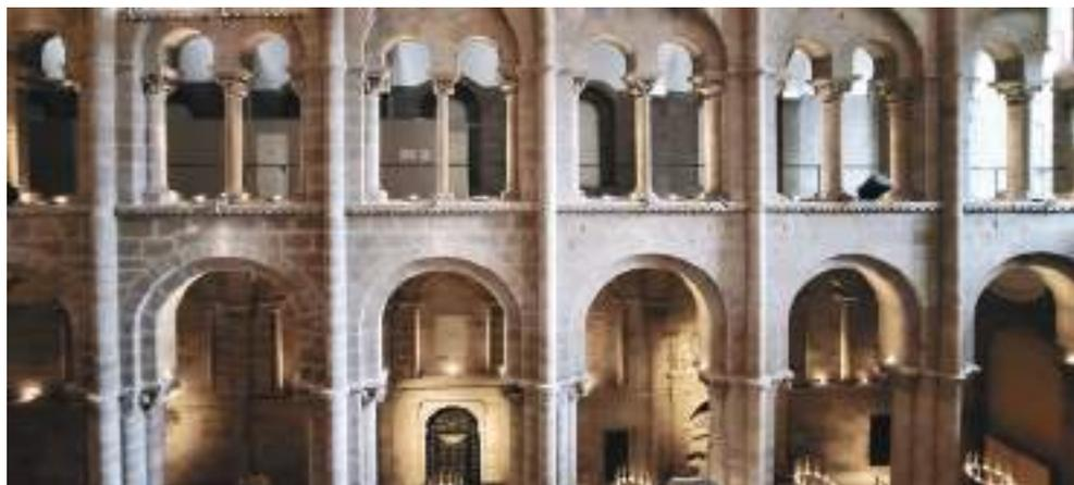
Figs. 3, 4. En los lienzos norte y sur de la nave central se aprecia un cambio significativo en la ejecución de la fábrica (tamaño de las juntas entre sillares, despiece, características de la piedra, etc..).
