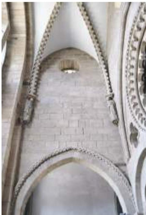
Fig. 62. El trazado de los arcos entre la zona central del nártex sobre la tribuna y las tribunas laterales resulta forzado, como si se hubiesen reaprovechado dovelas. Además sus claves poseen un taqueado diferente al resto de las piezas.
