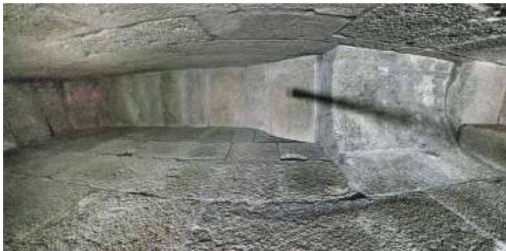
Fig. 57. Vista contrapicada del ándito norte con posibles mechinales de estructura de madera y arco incompleto a la derecha.
