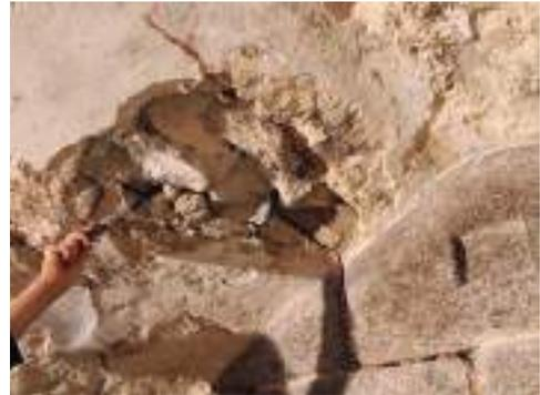
Fig. 69. Fractura en el muro norte del cuerpo central y en la bóveda antes de retirar el revoco. La mano señala la posición donde apareció la moneda.
