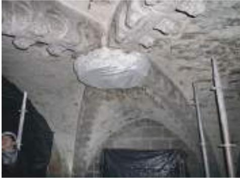
Fig. 68. A la izquierda el cuarto de bóveda que da hacia la fachada del Obradoiro, cuyo revestimiento se conservaba en mejor estado que los otros tres cuartos.
