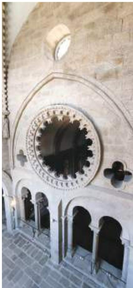
Fig. 48. El arco apuntado circundado por el baquetón que arranca de la repisa del cuerpo bajo de la tribuna se construye para aumentar el espesor del muro este del cuerpo central, y está desplazado en relación al eje del óculo.
