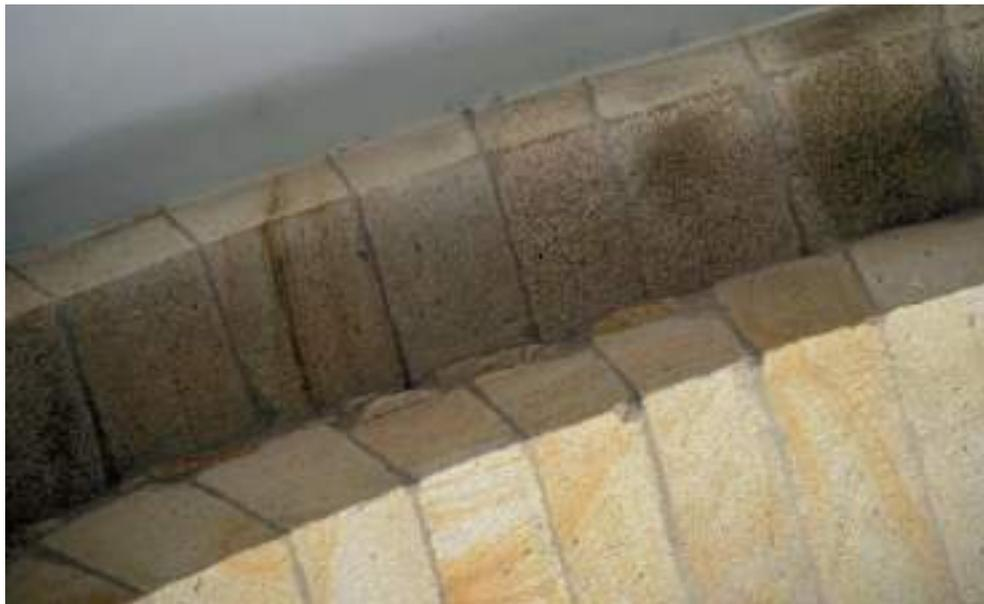
Fig. 66. El arco central barroco parece estar acuñado bajo el arco románico.
