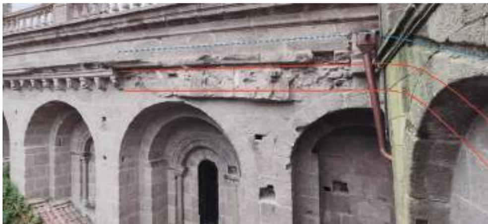
Fig. 18. Cornisa perdida que denota la existencia en algún momento de una bóveda de medio cañón. Obsérvese a la derecha de la imagen la traza de la bóveda de medio cañón y la roza del tejado sobre la torre norte. En rojo la posición de esta bóveda y en azul el nivel de cubierta de teja sobre esta.
