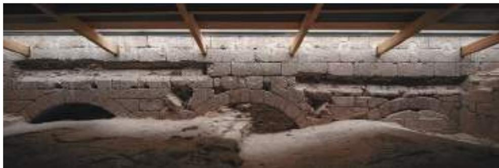
Fig. 16. Secuencia de arcos contrafuertes a lo largo del muro sur.
