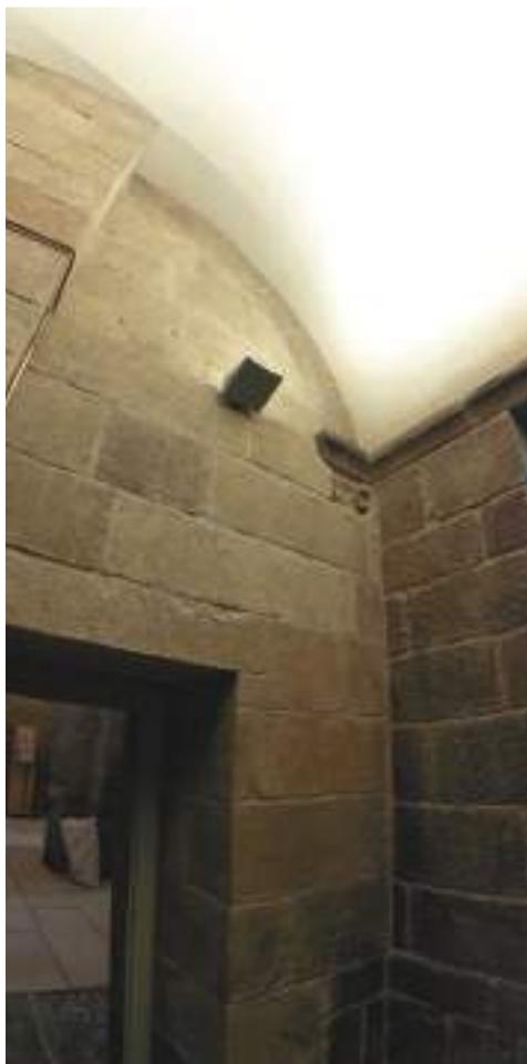
Fig. 38. C05. Vista del arco situado en la sala norte, en cuyo arranque se conserva el capitel original embebido en el macizo renacentista.
