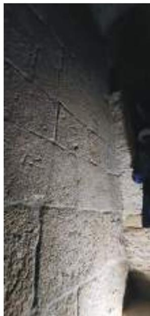
Fig. 26. Roturas en el interior de la torre sur inmediatamente antes del nivel de tribuna.
