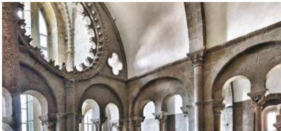
Fig. 51. El encuentro del óculo con la pilastra central obliga a adaptar el capitel al espacio disponible; bajo la bóveda asoma el perfil del arco de descarga, a modo de arco fajón.
