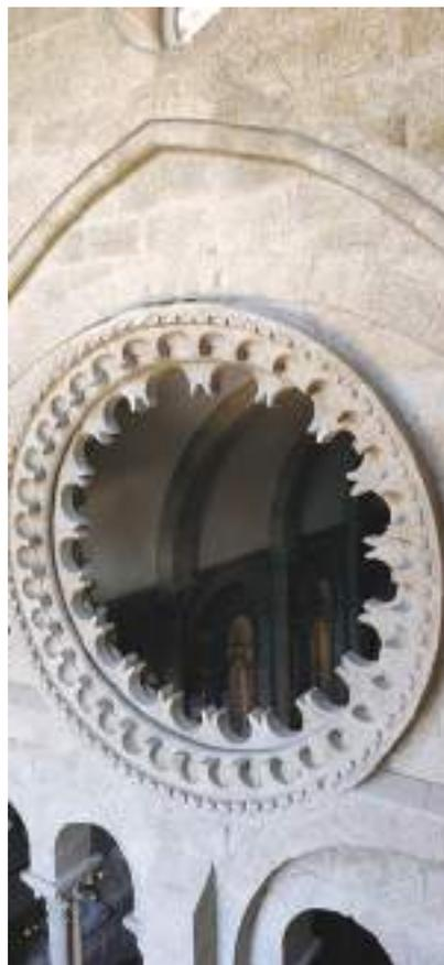
Fig. 50. Vista general y detalle de la clave del arco apuntado deforme; obsérvese una de las dovelas superiores del fajón embebido caída con respecto al resto.
