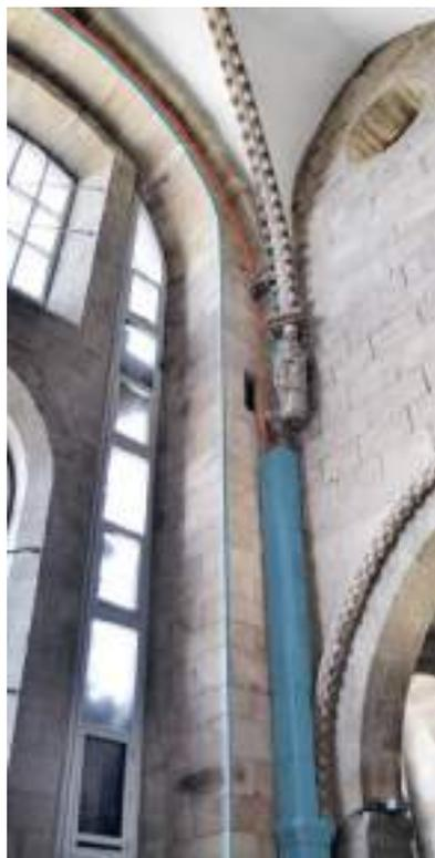
Fig. 64. Es probable que este tramo de la pilastra sombreado en azul fuera modificado o añadido por Casas respecto a una pilastra románica que sobresaldría un poco menos del muro.
