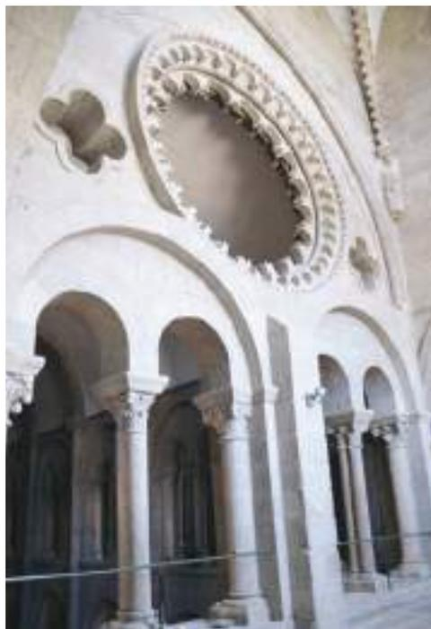
Fig. 61. La pilastra o contrafuerte central, al igual que los huecos cuadrifolios, serían añadidos por Casas.
