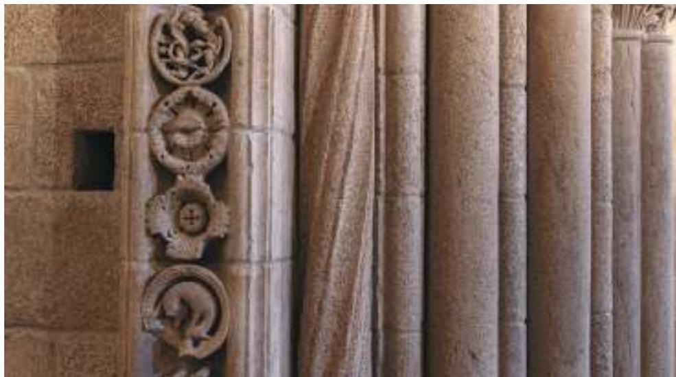
Fig. 42. C08. Pilastrón central bajo la fachada occidental, profusamente decorado; se conserva el mechina para cierre de puertas mediante tranca de madera. Se aprecia la línea de sillares discontinua.
