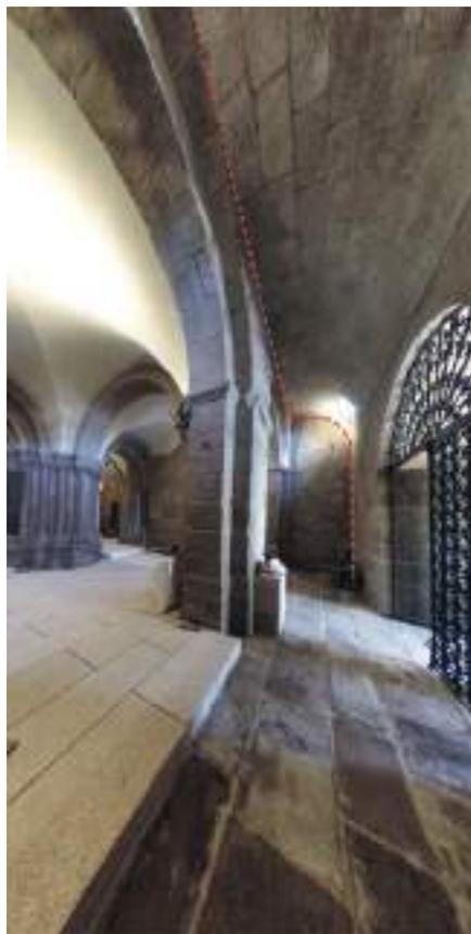
Fig.43. C09. Adición de bóveda de 1/4 de cañón durante la intervención renacentista.
