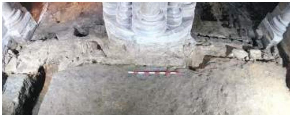
Fig. 13. El pilar avanza con su propia cimentación respecto a la bancada 1, que serían los restos de un muro de mayor altura (escarpa) que separaría la berma de la muralla del posible foso o estancamiento de aguas del que hemos hablado.
