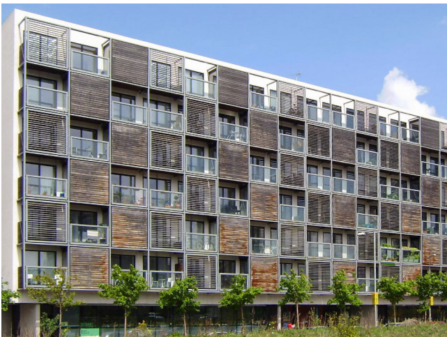
Рис.5 Житловий будинок з рестораном і офісними приміщеннями на першому поверсі, Манчестер
