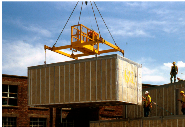
Рис.18 Монтаж модуля із захисної клітки
