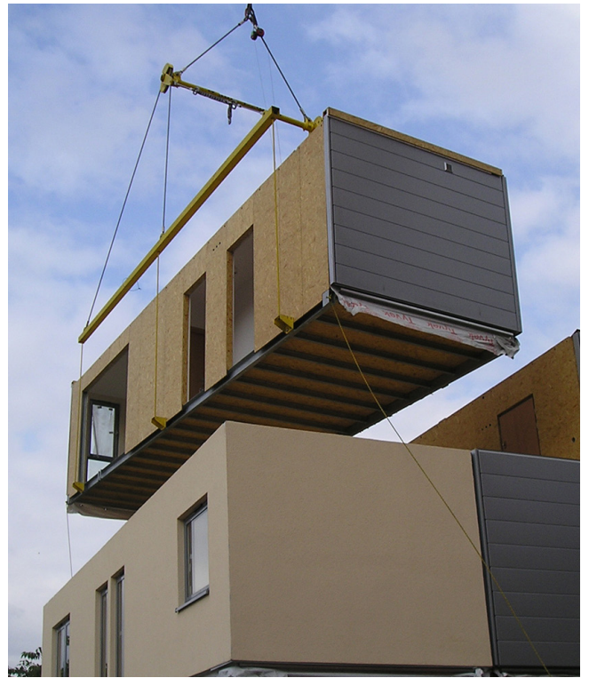
Рис.8 Установка модуля з частково відкритими сторонами
