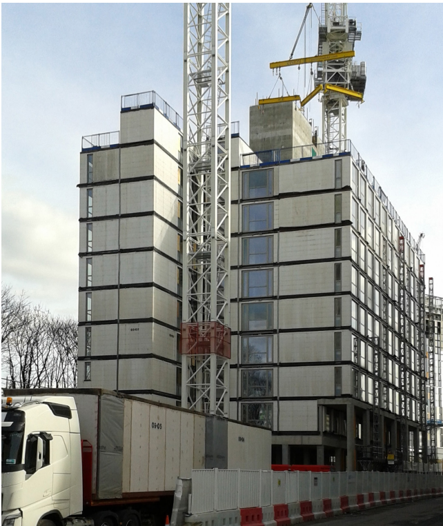
Рис.7 Збір модульних будинків в Льюїшемі, Лондон
