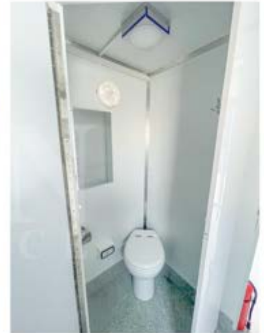
BAÑOS Y LAVATORIOS
