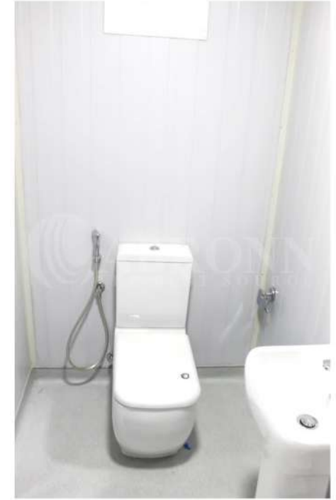
BAÑOS Y LAVATORIOS
