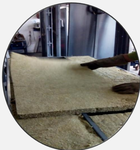
RELLENO DE LANA MINERAL COMO AISLANTE TERMICO
