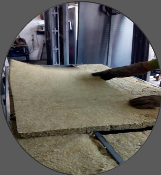
RELLENO DE LANA MINERAL COMO AISLANTE TERMICO
