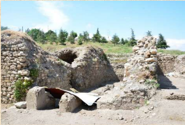
Foto 17: Doğu Cephesi – Külhan Bölümü
