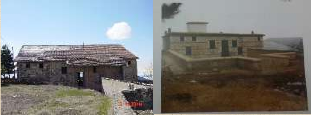
Şekil 11. Restorasyon Öncesi Doğu Cephesi(Karakas,2008)
