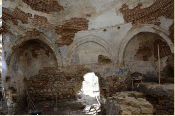
Foto 6: Soğukluk Batı Duvarı
