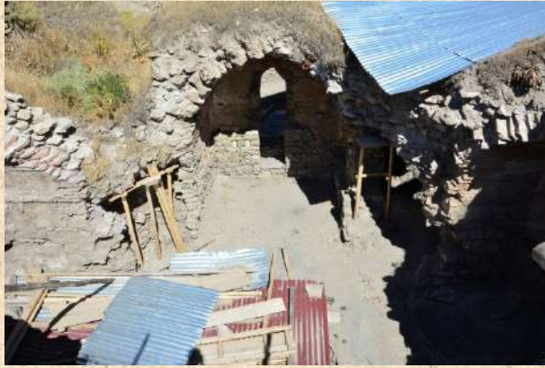
Foto 15: Ilıklık, Kubbeye geçişi sağlayan pandantifler
