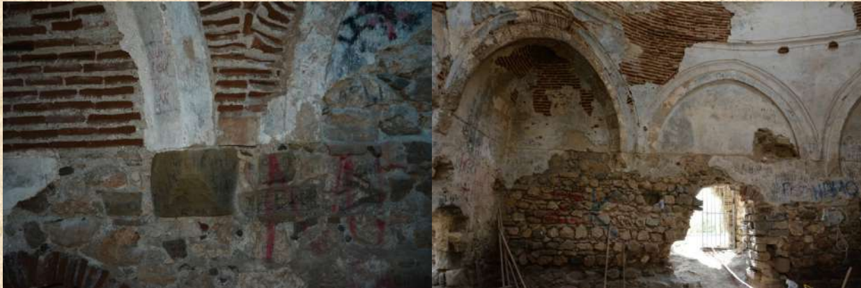
Foto 9: Z03 Soğukluk MekanıTromp Kemerli Bitiş Elemanı
