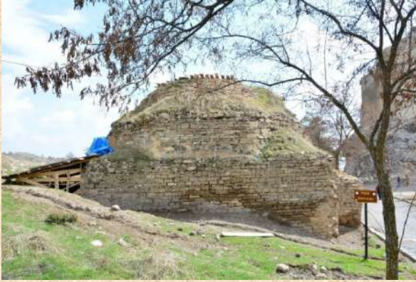
Foto 1: Yapının Ana Girişi (Güney Cephesi)
