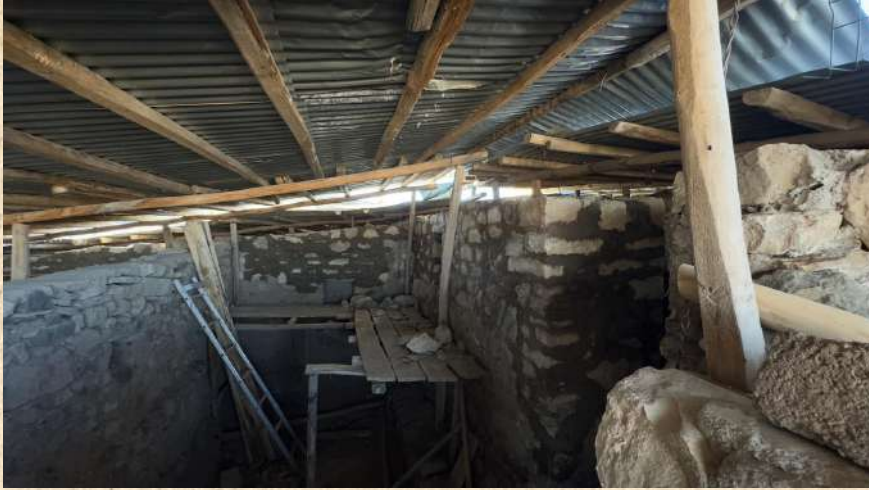
Foto.12: Sıbyan Mektebi onarım çalışması sonrası görünüm (2025).
