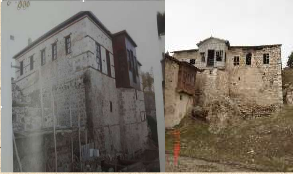
Şekil 9. Restorasyon Öncesi Batı Cephesi(Karakas,2008)
