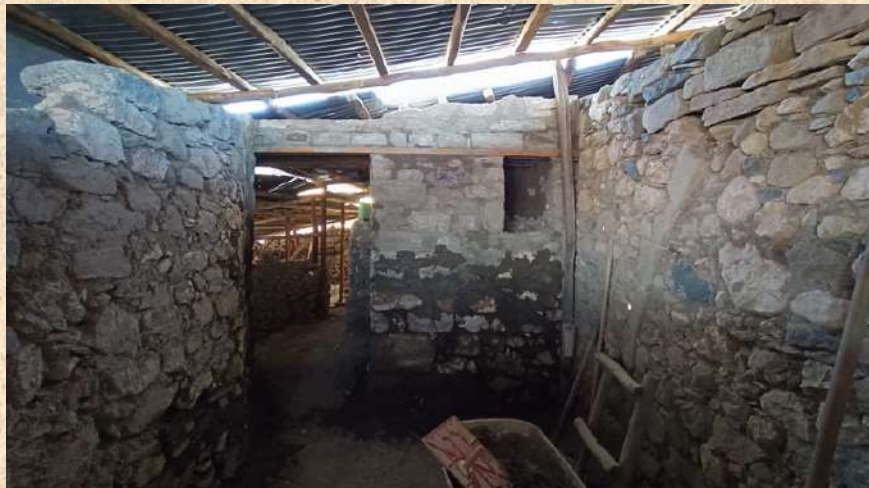
Foto.13: Sıbyan Mektebi onarım çalışması sonrası görünüm (2025).
