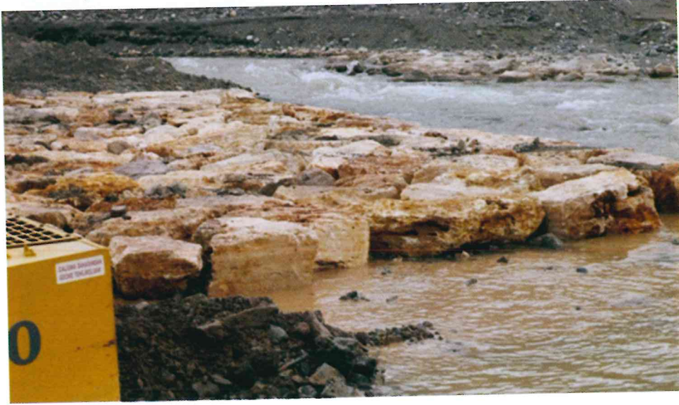
A1 ayağı çevresinde yapılan araştırma kazısında çeşme açığa çıkarıldı. Bu kısmın beton sökümü sırasında zarar görmemesi için toprak ile kapatılarak çalışmalara devam edilmiştir.
