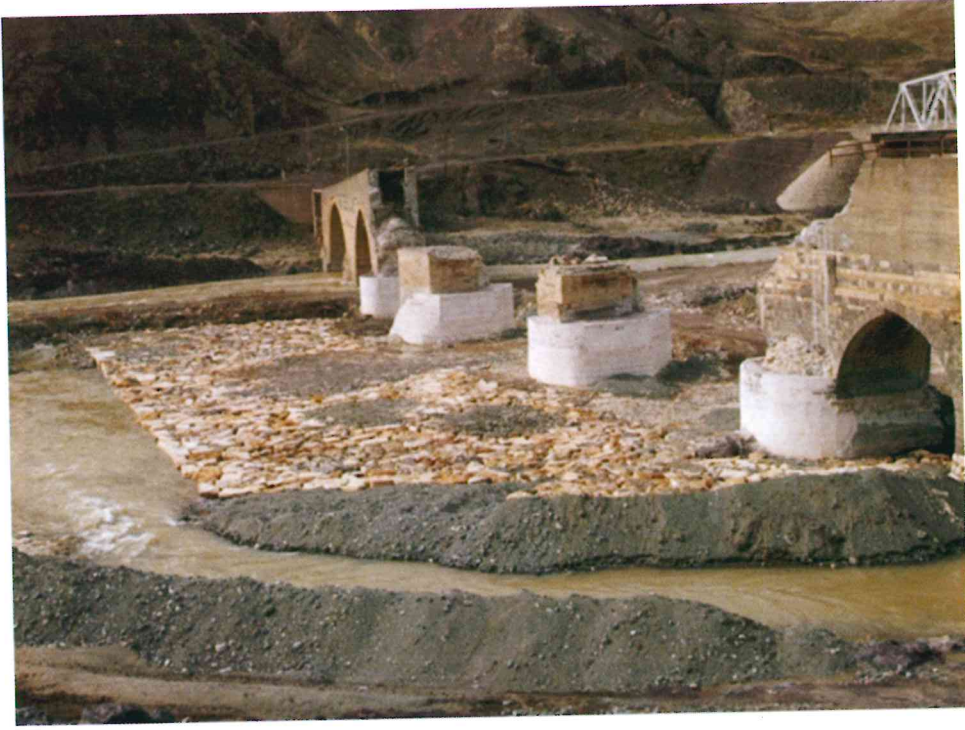
Köprü tahkimat çalışmaları büyük ebatlı ocak taşları kullanılarak ve taşların birbirine geçişi düşünülerek belirlenen kotta yapılmıştır.
