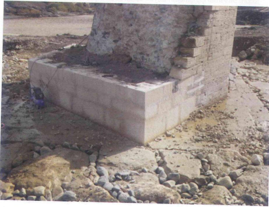
Sökümü yapılacak taşlar numaralandırıldıktan sonra söküldü.
