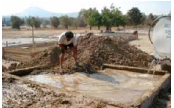
Şekil 24. Dünyada geleneksel teknikler ile kerpiç malzeme yoğurma ve kalıplama.
