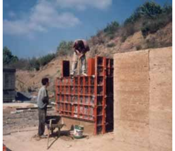
Şekil 31. Beton kalıbı, "Frosh" ile tokmak.
