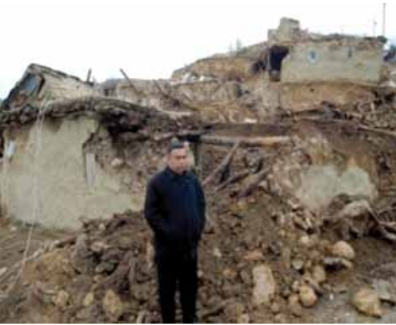
Şekil 12. Elazığ depremi, 8 mart 2010, hasar gören duvar ve döşeme türleri.
