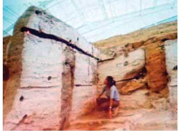
Şekil 18. Çatalhöyük, 9500 yıl önce kerpiç duvarda yatay hatlı (lan Hodder) narme iskelet 17 .
