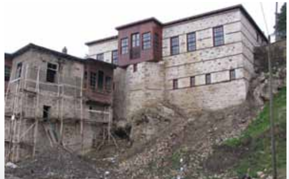
Resim 4. Hacı Kerim Sungurlu Konağı Güneybatı Görünüşü.
