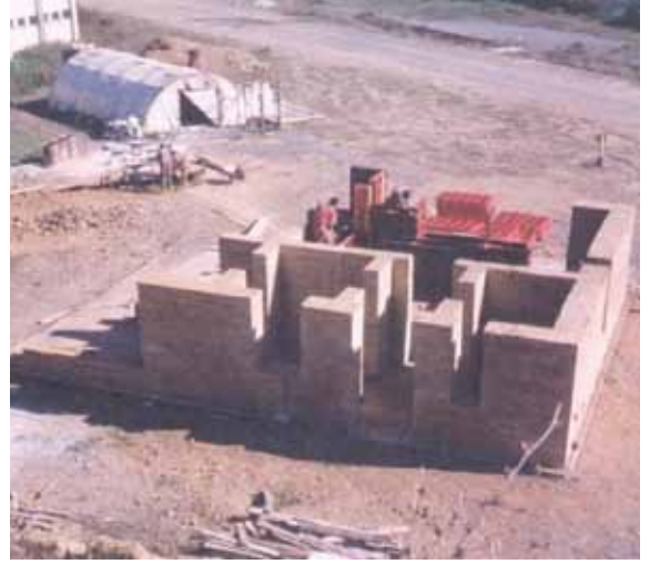
Şekil 29. Beton kalıbı tekniği ile kerpiç yapı.
