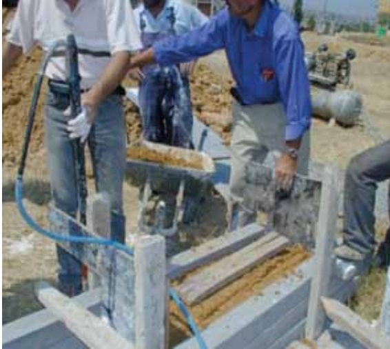
Şekil 30. Kompresör ile Tokmalama.
