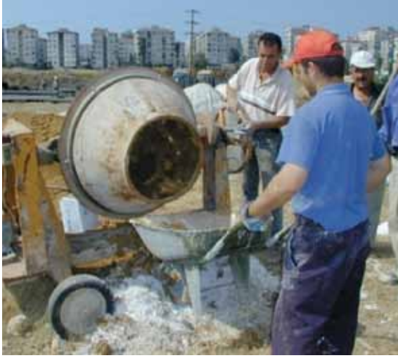
Şekil 28. Betonier ile karıştırma.
