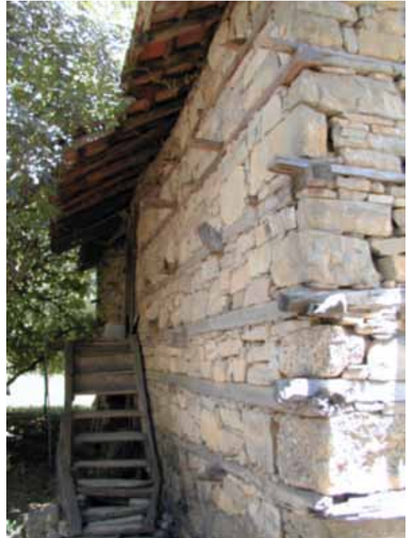
Şekil 19. Köprülü kanyon, taş kuru duvarda yatay hatlı.
