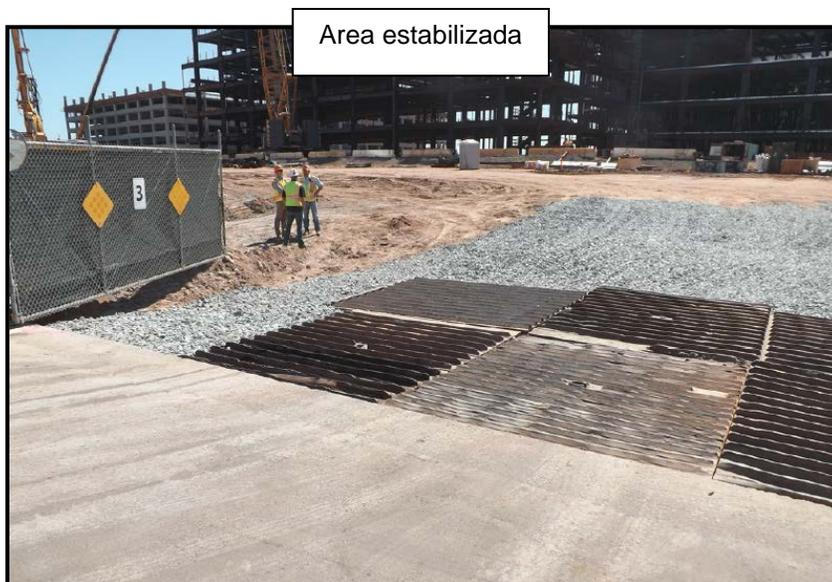
Debido a que las entradas / salidas estabilizadas sólo son moderadamente eficaces, este BMP en particular debe usarse junto con el barrido de calles y debe someterse a inspección y mantenimiento de rutina.
