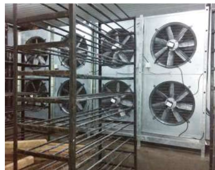
تركيب انفاق التجميد Blast Freezer
