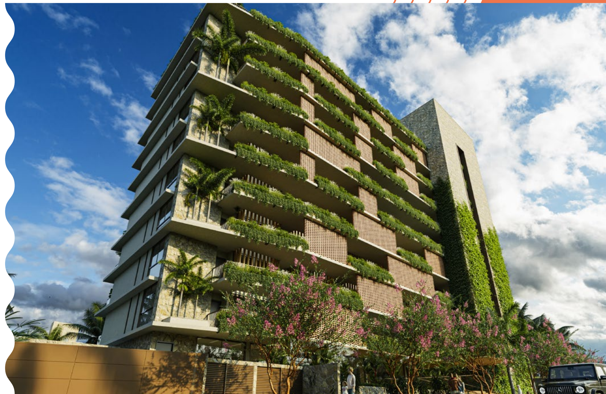
FACHADA - BLOCO B
