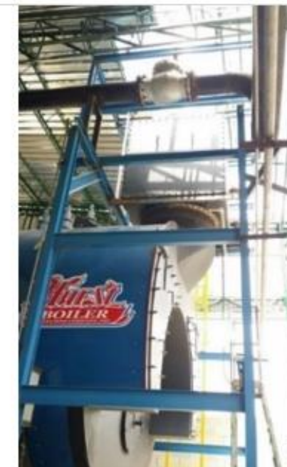
Compañía Envasadora del Atlántico Economizador externo Caldera de 1500 BHP
