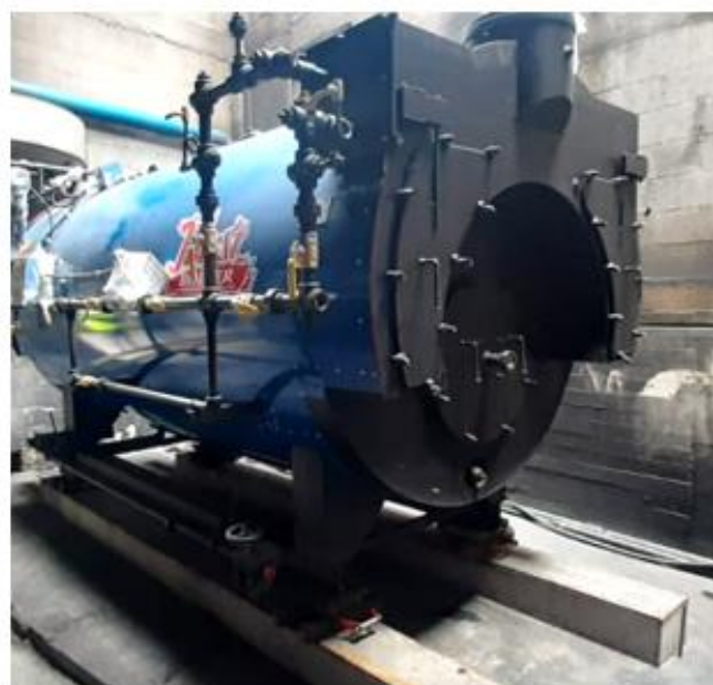
Fibertex Economizador integrado Caldera 150 BHP
