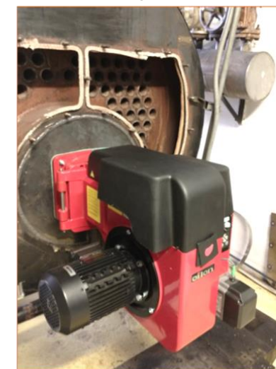
Instalación quemador Oilon
