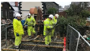
Llanfair Talhaiarn (TH): concrete pour for culvert
