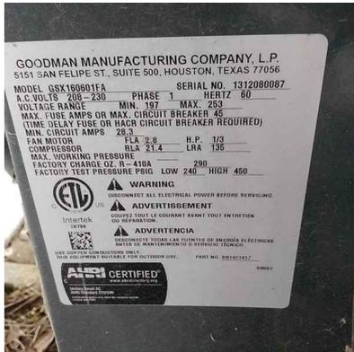
*Cooling System(s) Tonnage:* 5 Ton -
