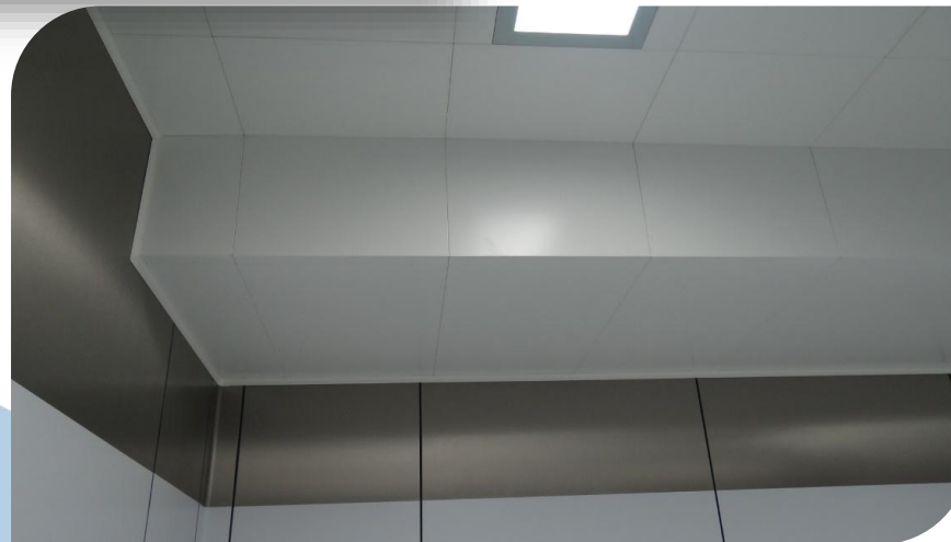
DETALLE ESTRUCTURA INSTALACION PLAFON Y SU CURVA SANITARIA
