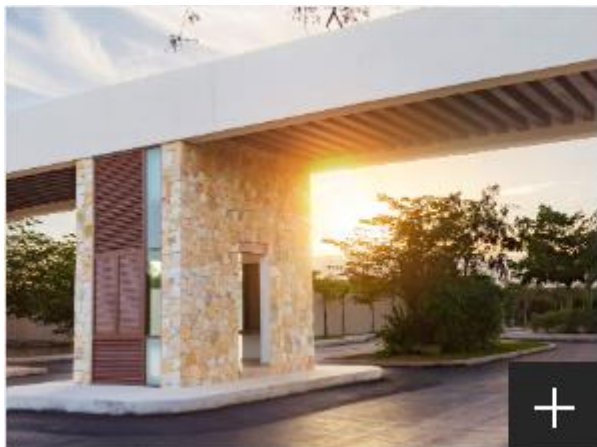
Pórtico de entrada y caseta de control de acceso
