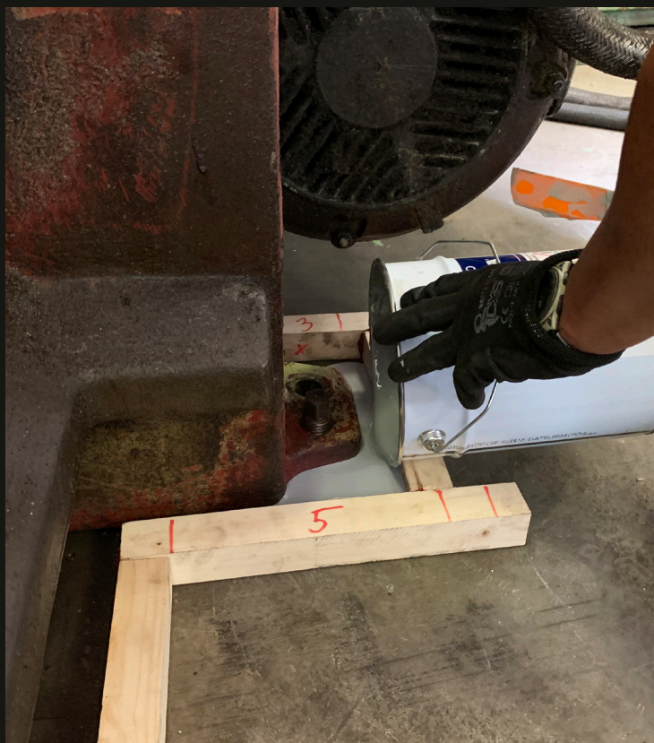
Pouring Belzona 7111
