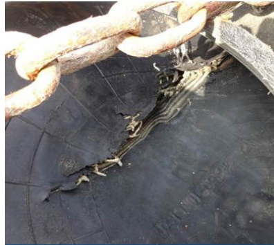
Torn Yokohama fender
