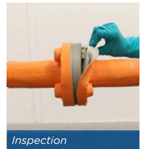
Belzona wrap applied
