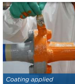
Belzona wrap applied
