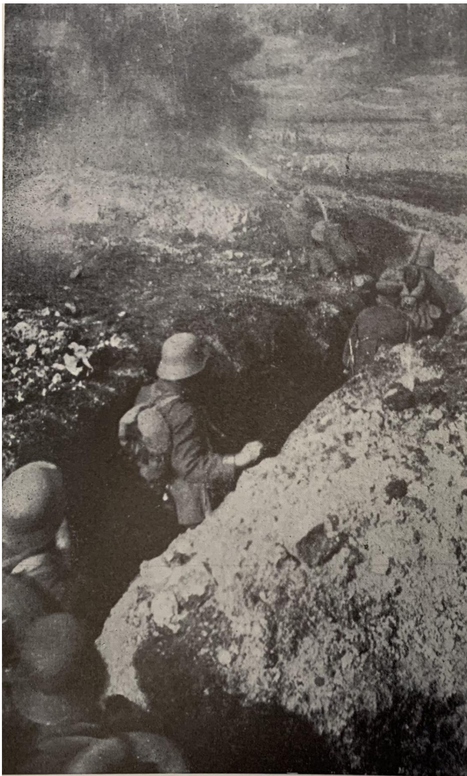
Aufrollen eines Grabens durch Flammenwerfer
