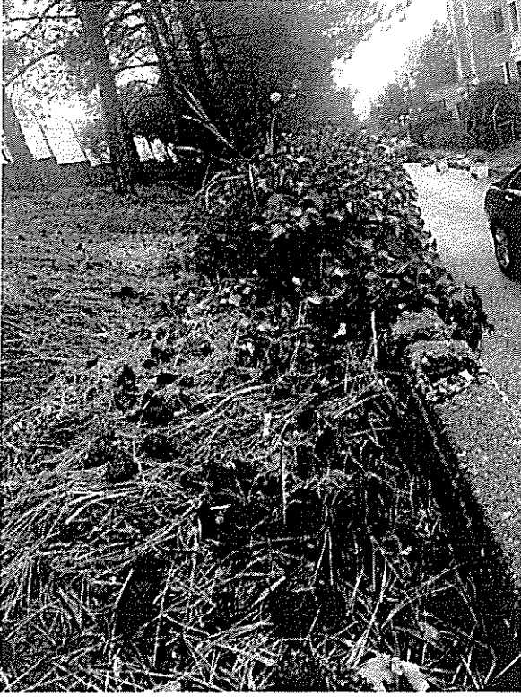
Fotoğraf -5: İstinat duvarı arkasındaki toprakta çökme
