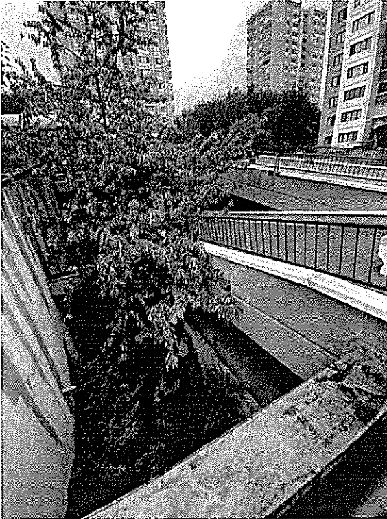
Fotoğraf -24, 25: Kapalı garajın yan tarafındaki betonarme perde istinat duvarlarında fenni teknik şartnamesine uygun olarak yeterli miktarda "Barbakan" bırakılmamış. Bu duvarların arkasındaki dolgu zemin içerisinde biriken çevre ve yağmur suları hem ilave itkiye hem de betonda bozulma ve donatıda korozyona neden olarak güvenlik açısından tehdit oluşturmaktadır.
