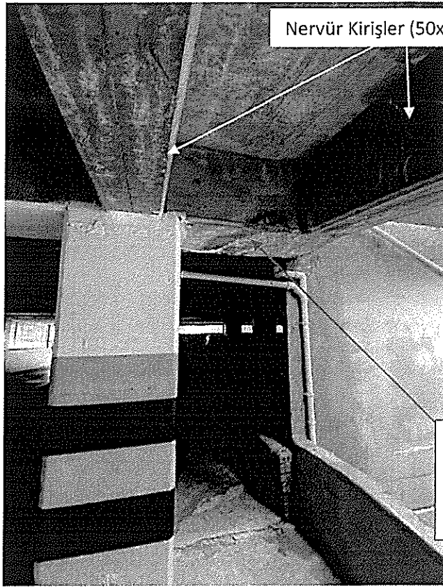
Fotoğraf -18,19: Fotoğrafta görüldüğü üzere rampalardaki 50x30'luk nervür kirişler, alt ve üst uçlarında, iki rampa arası dilatasyon yerlerinde kendilerine dik istikamette, yine 50x30 cm ebatlarında 600 cm açıklığında iki kirişe bağlanıyor.
