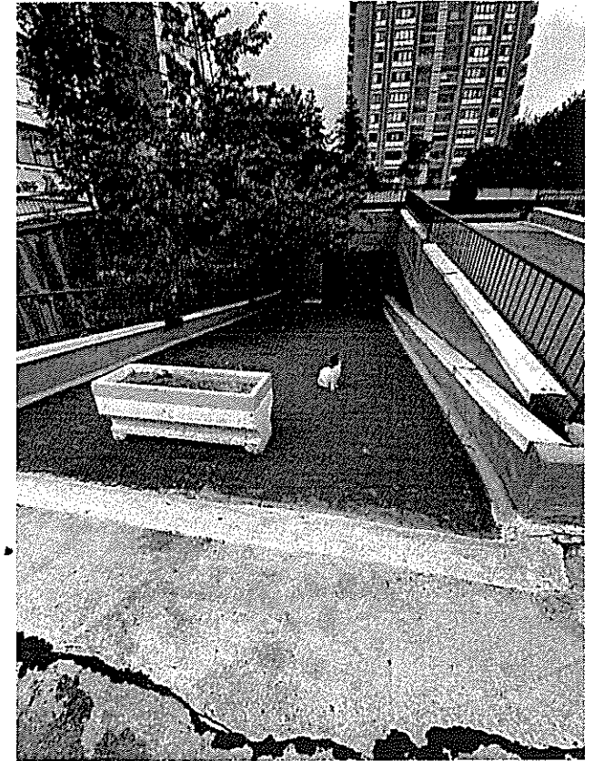
Foto-11,12,13,14,15: Kapalı otopark girişlerinde döşemelerin üzerine 10 cm kum serilerek dekoratif hazır beton taşlarla kaplandığı ifade edildi. Aşırı yağışlarda bu döşemelerde çok fazla su biriktiği, bir türlü kurumadığı, bu suların drenajı için alınan önlemlerin (açık kanallar, yan parapetlerin delinerek suların akıtılması vs) de yeterli olmadığı söylenmiştir.
