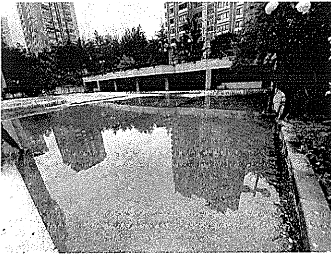
Fotoğraf -20,21: Kapalı garajın üstündeki açık otopark alanında yağmur suları birikerek göllenmekte ve asfalt kaplamadaki çatlaklardan betonarme taşıyıcı sisteme sızarak hem betonda bozulmalara hem de donatıda korozyona neden olmaktadır.
