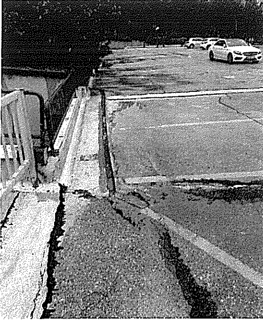
Fotoğraf -22,23: Kapalı garajın üstündeki açık otopark alanında biriken suların asfalt kaplamadaki çatlaklardan altındaki betonarme döşemeye sızmasını önlemek için çatlaklara sıcak bitüm dökülerek önlem alınmaya çalışılmış. Ancak bu palyatif önlemler yeterli sonuç vermemiş.
