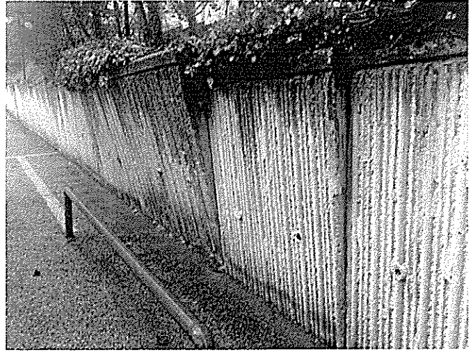
Fotoğraf -1,2,3,4: D8 Blok önündeki bahçe istinat duvarında oluşmuş dönmeler ( \emptyset \sim \%11 )
