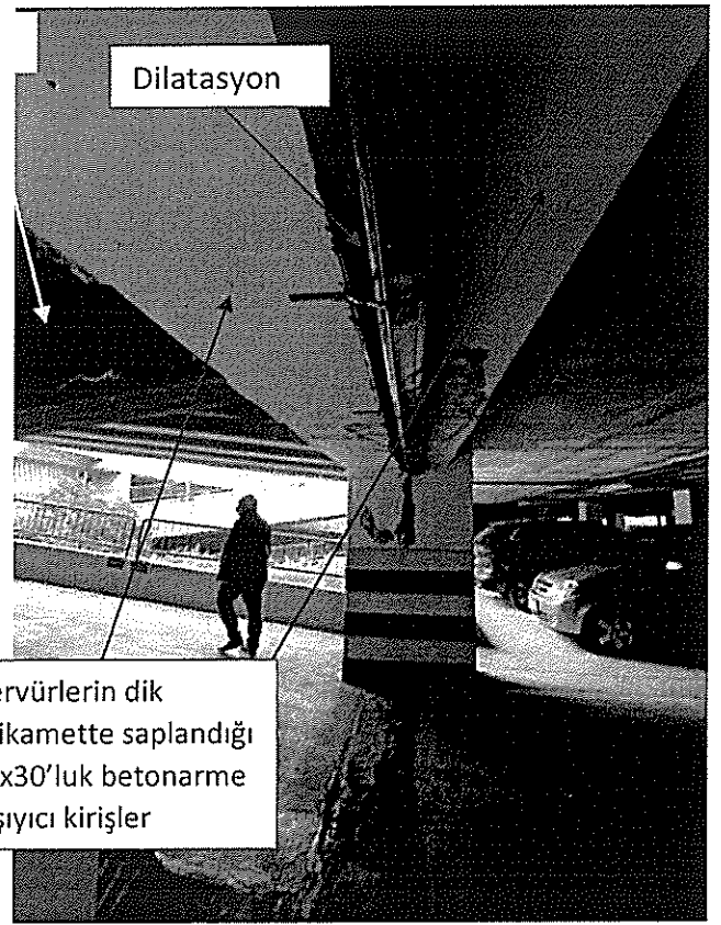
Fotoğraf -18,19: Fotoğrafta görüldüğü üzere rampalardaki 50x30'luk nervür kirişler, alt ve üst uçlarında, iki rampa arası dilatasyon yerlerinde kendilerine dik istikamette, yine 50x30 cm ebatlarında 600 cm açıklığında iki kirişe bağlanıyor.
