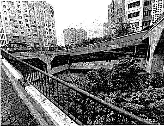
Fotoğraf -9,10: Kapalı otopark, bir tarafta 2, diğer tarafta ise 3 katı gömülü olarak inşa edilmiş. Katlar birbirine betonarme nervür kirişli döşeme rampalarla bağlı. Giriş çıkışlar bu rampalardan sağlanıyor.
