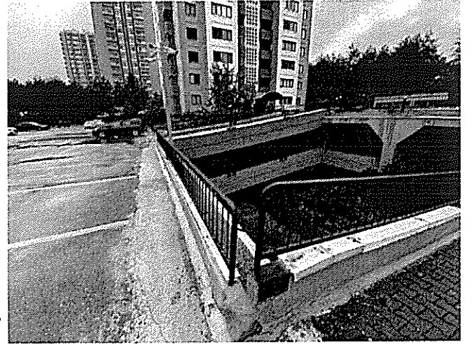
Fotoğraf -9,10: Kapalı otopark, bir tarafta 2, diğer tarafta ise 3 katı gömülü olarak inşa edilmiş. Katlar birbirine betonarme nervür kirişli döşeme rampalarla bağlı. Giriş çıkışlar bu rampalardan sağlanıyor.
