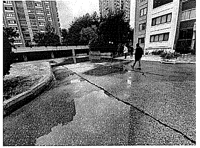
Fotoğraf -20,21: Kapalı garajın üstündeki açık otopark alanında yağmur suları birikerek göllenmekte ve asfalt kaplamadaki çatlaklardan betonarme taşıyıcı sisteme sızarak hem betonda bozulmalara hem de donatıda korozyona neden olmaktadır.
