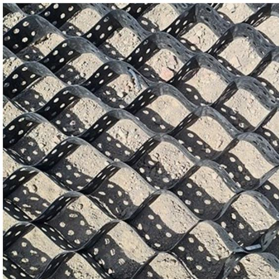
Las Geoceldas son un geosintético formado por una estructura tridimensional semirrígida en forma de panal de abeja que es rellena de tierra vegetal, grava, arena, cemento, concreto u hormigón, entre otros materiales. Las Geoceldas están formadas por tiras de polietileno de alta densidad estabilizadas contra la radiación ultravioleta y unidas mediante soldaduras por ultrasonido, que aportan una resistencia estructural no comparable con otros sistemas.
