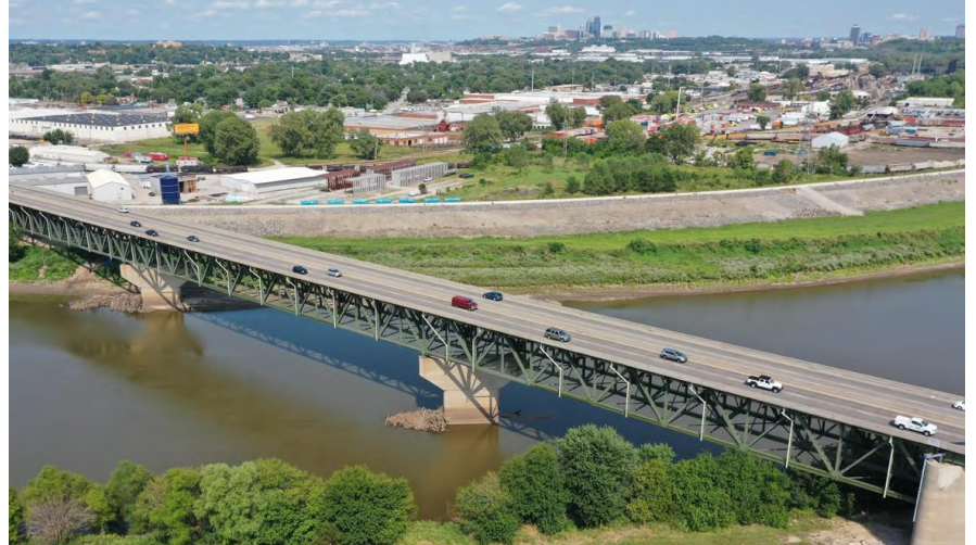
El puente de la calle 18, construido en 1959, se acerca al final de su vida útil.
