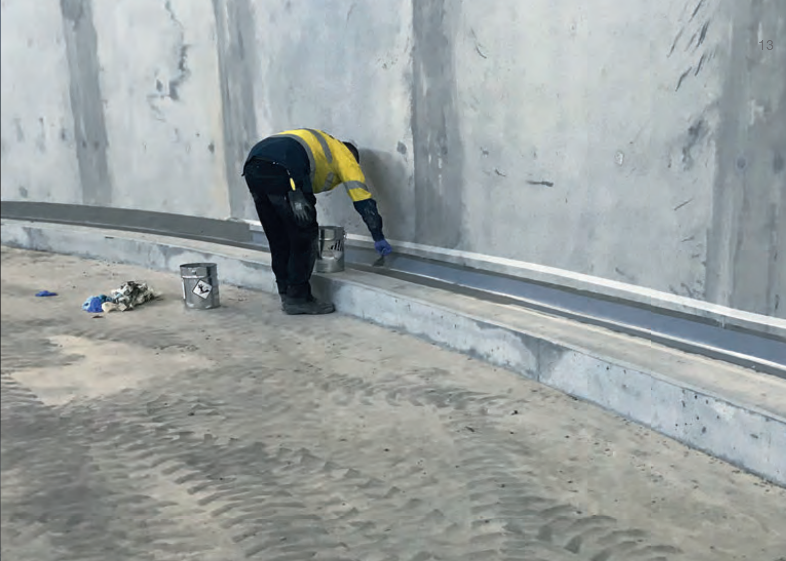
Abdichtung unter Wasser Sealing even under water
