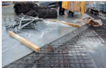
Decken- / Sohlen-Abschalung Ceiling / basement casing
