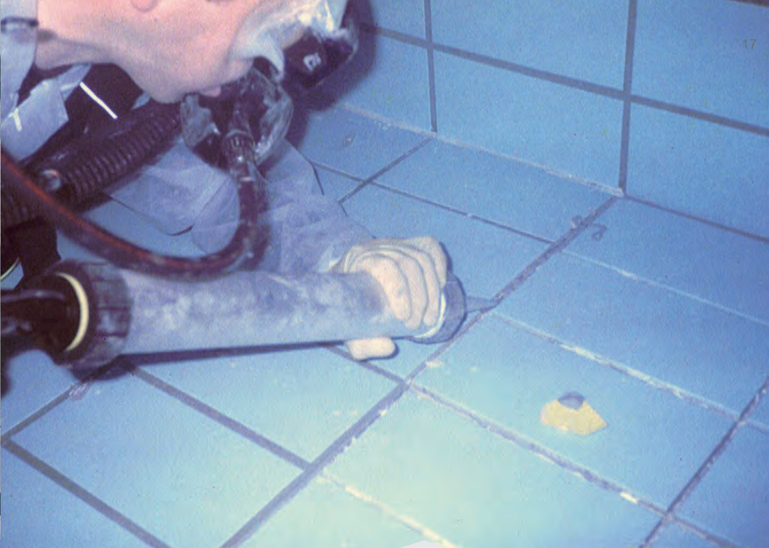
Betonplatten-Abdichtung Concrete slab sealing
