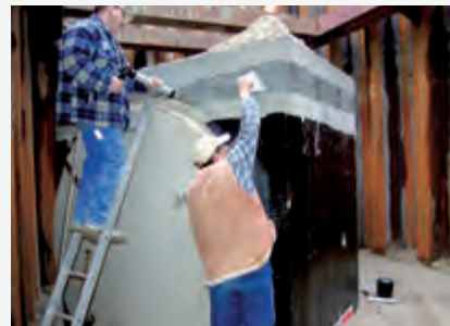
Schachtdeckelabdichtung Manhole cover sealing
