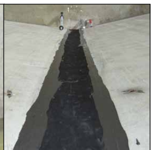
Druckwasserdichtes hochflexibles Folien-Abdichtungs-System für alle Betonfugen
