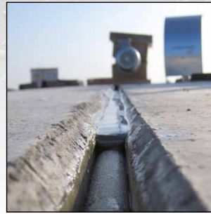
Fugenprofile und dauerelastische Dichtmasse zur Abdichtung von Dehnfugen, JGS-beständig
