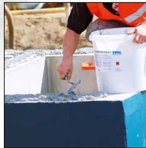
Starrer PC-Mörtel zur Reprofilierung von Beton oder flexibler PC-Mörtel zur Verklebung und Abdichtung
