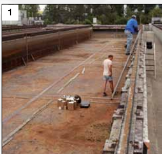
Abdichtung eines Klärbeckens Sealing of a sewage plant
