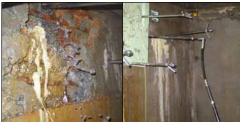
Schnelle und effektive Systeme zum sofortigen Stoppen von Wassereinbrüchen Fast reacting and effective systems for immediate stopping of water inrush
