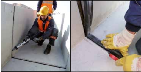
Fugenprofile und dauerelastische Dichtmasse zur Abdichtung von Dehnfugen Joint profiles and sealing compound for expansion joints
