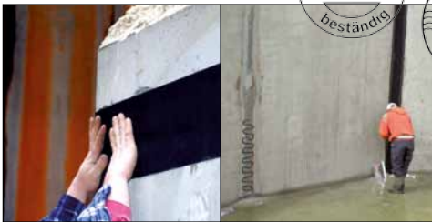
Druckwasserdichtes, hochflexibles Folien-Abdichtungs-System für alle Betonfugen Waterproof and highly flexible membrane sealing system for all joints
