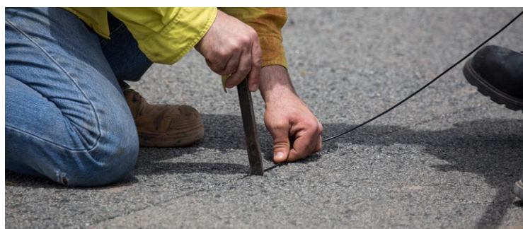
Instalación de los lazos inductivos.
